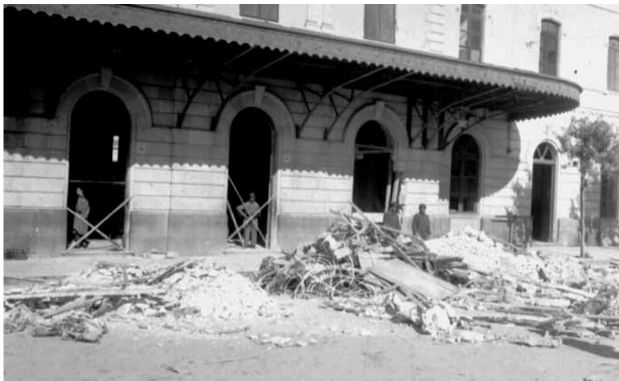
Danni da incursione nemica all'esterno del piazzale della stazione ferroviaria.
