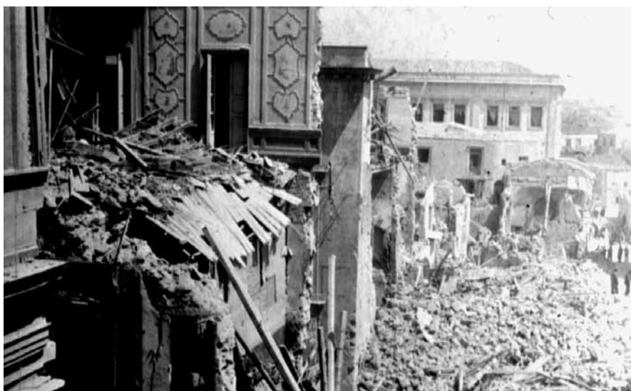
In fondo alla via, con danni subiti ma saldo in piedi, si nota l'edificio scolastico di via dei Mergulensi.
