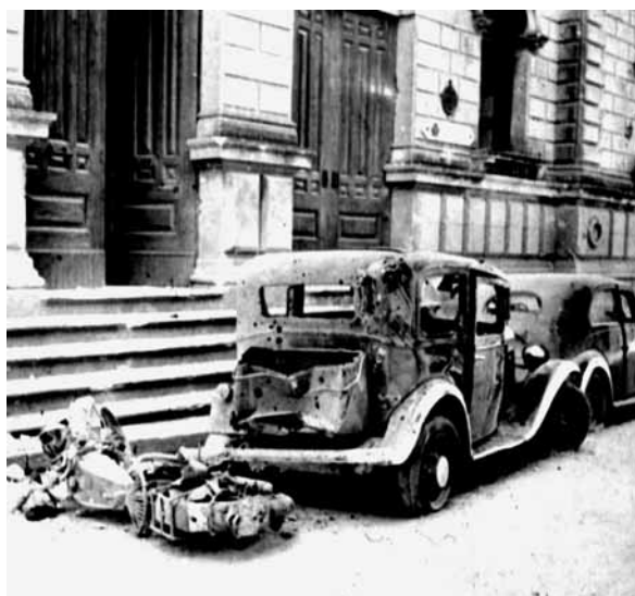
Moto e auto danneggiate davanti all'ingresso della Camera di Commercio.
