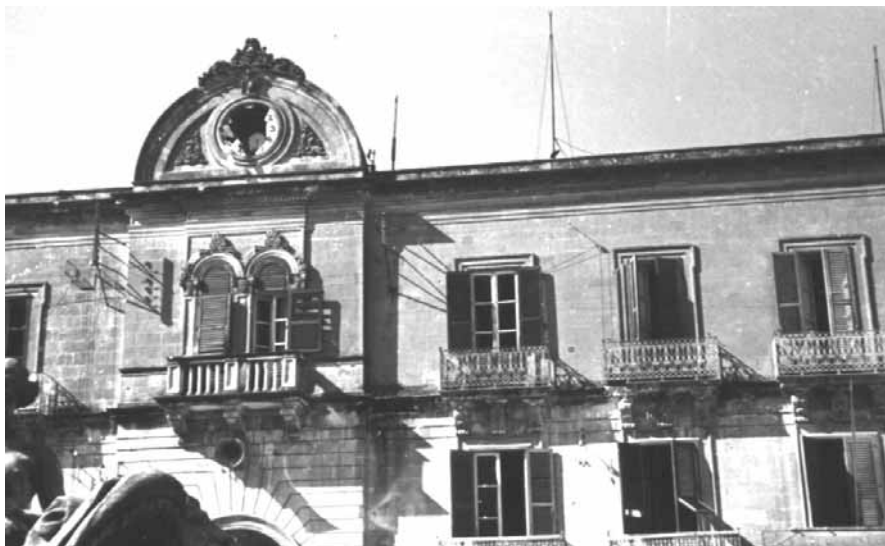
Una scheggia ha sfondato l'orologio della Banca d'Italia. Notare l'apertura del balcone ancora a bifora, diversamente dalla trifora attuale.
