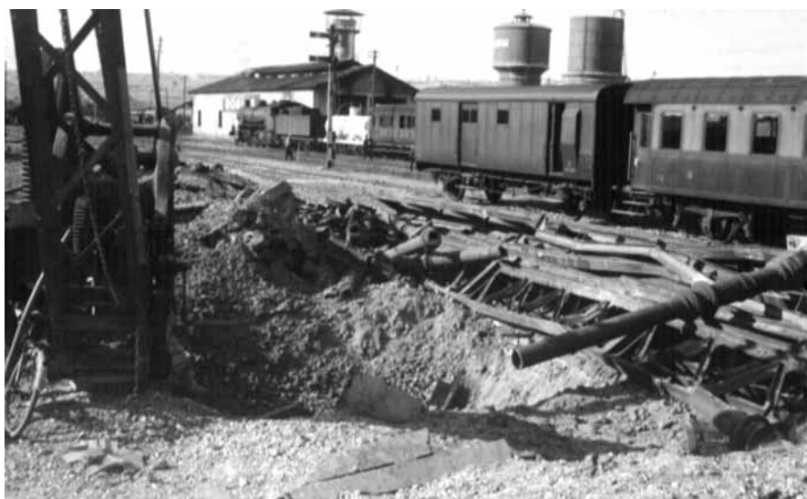
Danni subiti all'interno della stazione FFSS.
